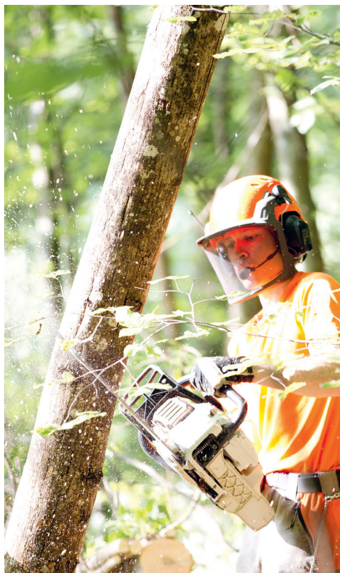
Derzeit sichert das Team des Forstreviers vor allem viel genutzte Strassen und Rastplätze vor spontanen Abstürzen. Diese können für die Waldbesucherinnen und -besucher gefährlich werden.
